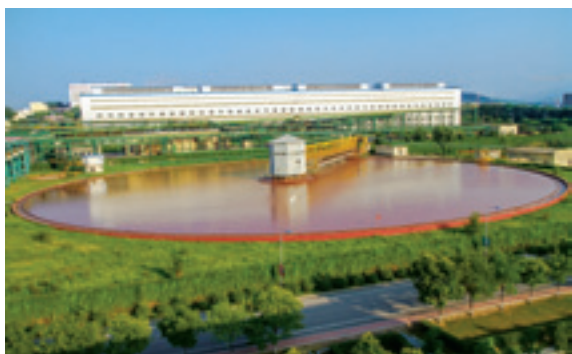
国内最大的直径 140 米尾矿沉淀系统
